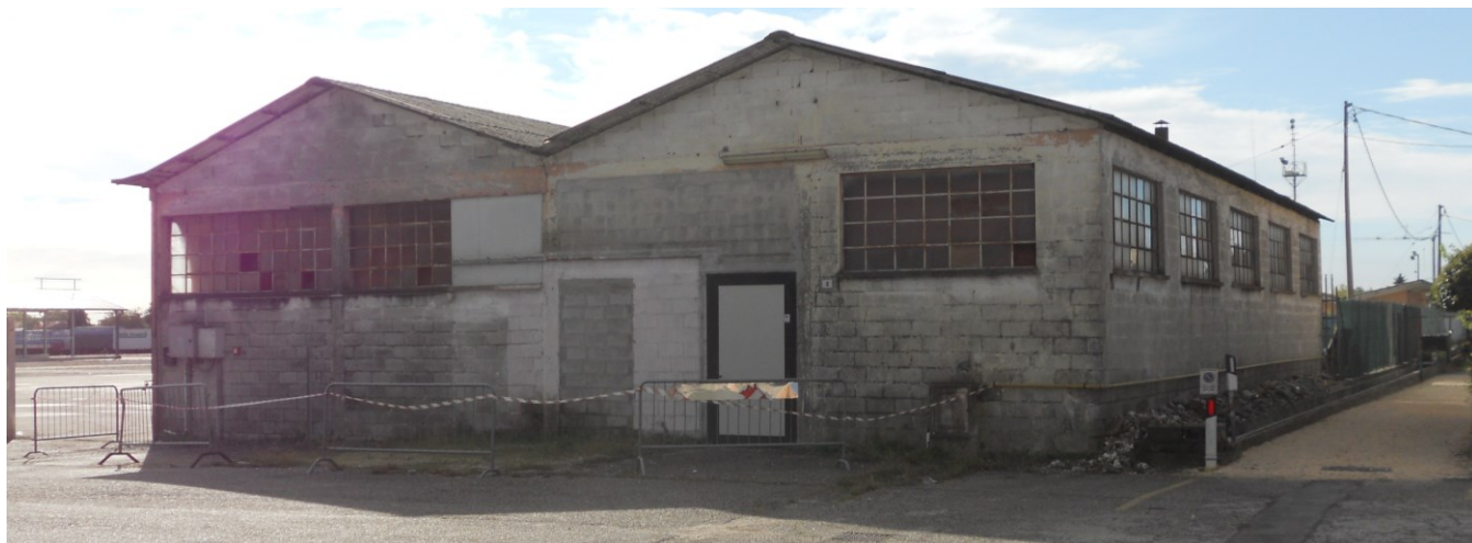
Foto 1: Magazzino della Protezione Civile di Santa Lucia di Piave – Prospetti nord e ovest visti dalla Strada
