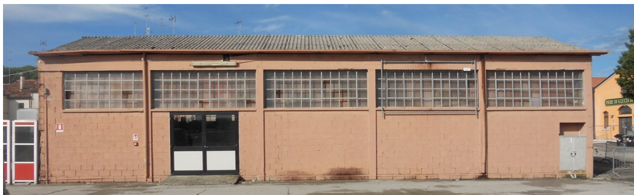
Foto 2: Magazzino della Protezione Civile di Santa Lucia di Piave – Prospetto est
