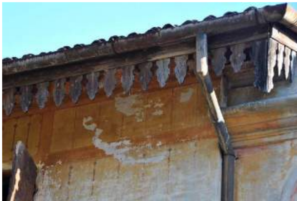
Particolare della cornice di gronda e della mantovana lignea
