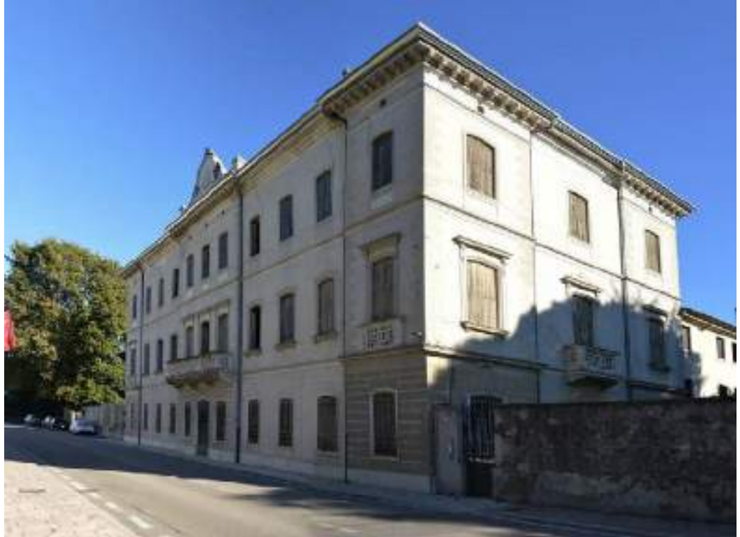
Sostituire foto con post lavori A Palazzo Ancilotto _ map. 170 sub 6 (In corso di restauro)
