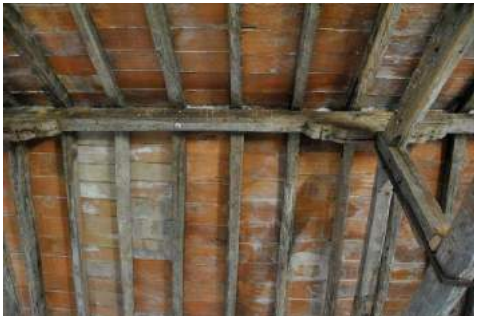
Intradosso della copertura con manto in tavelloni forati
