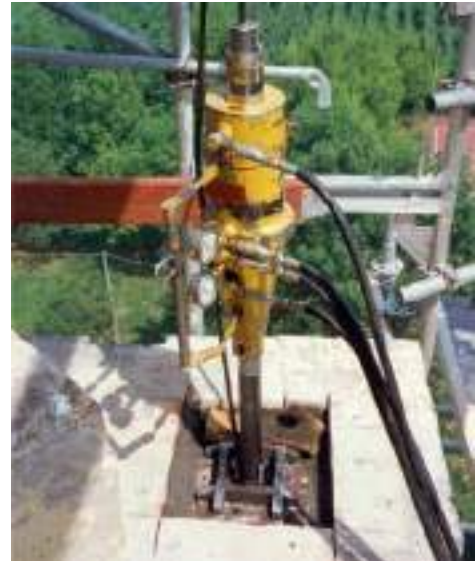
Tiranti attivi occultati con martinetto per l'attivazione del tirante
