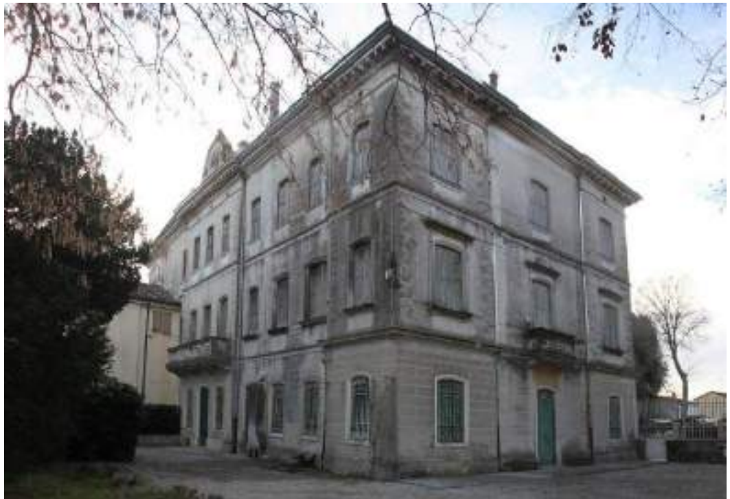
A Palazzo Ancilotto _ mappale 170 sub 6 (in corso di restauro)
