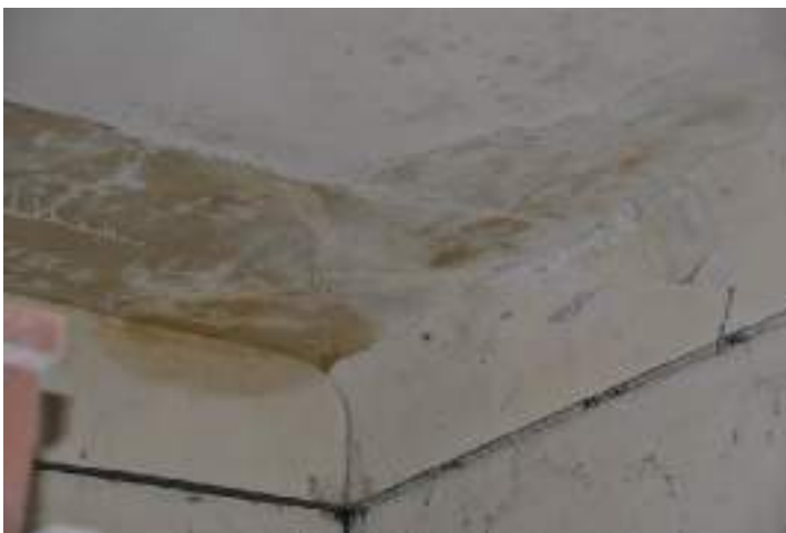
Finiture interne con tinteggio a calce delle pareti e dei soffitti e stato conservativo dei soffitti
