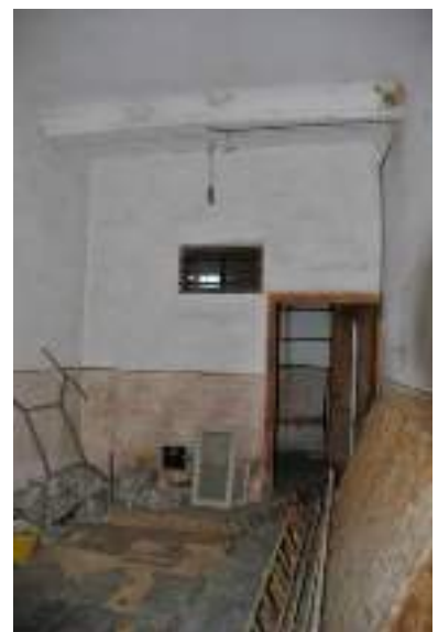
Finiture interne con tinteggio a calce delle pareti e dei soffitti e stato conservativo dei soffitti
