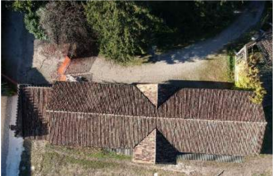
Vista del manto di copertura dall'alto
