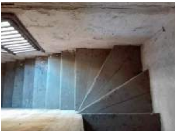
Scala esistente in legno
