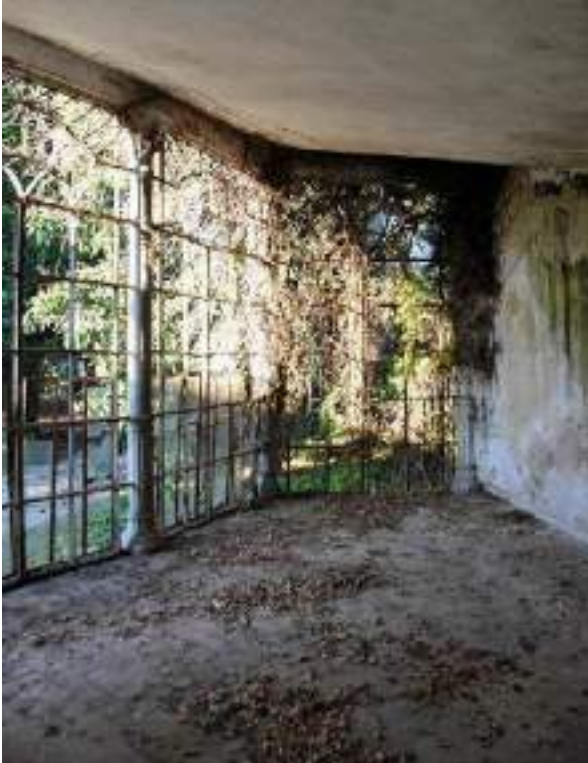
Interno della serra con pavimento in cotto
