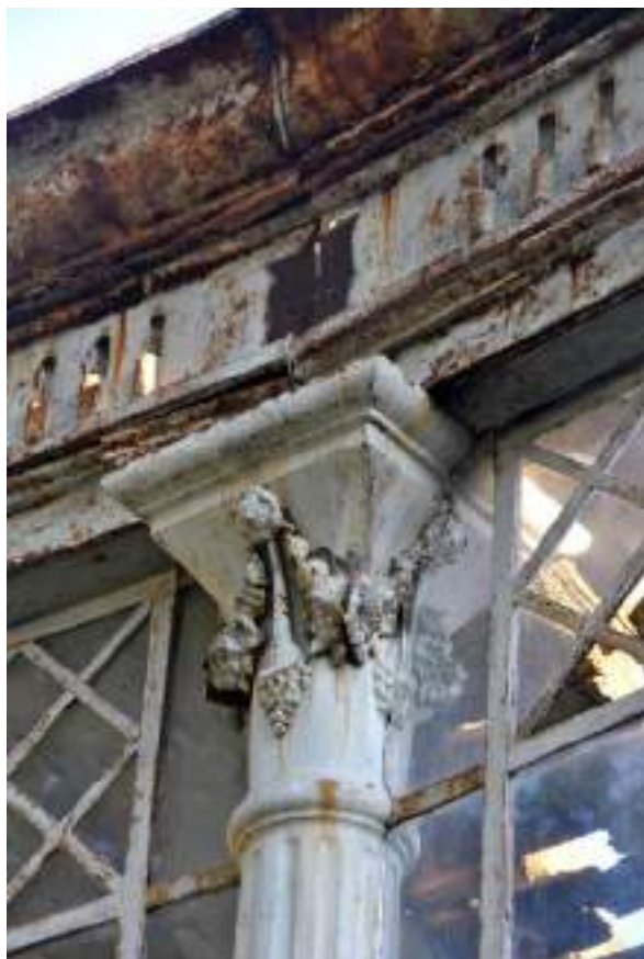
Particolare della colonna in ghisa
