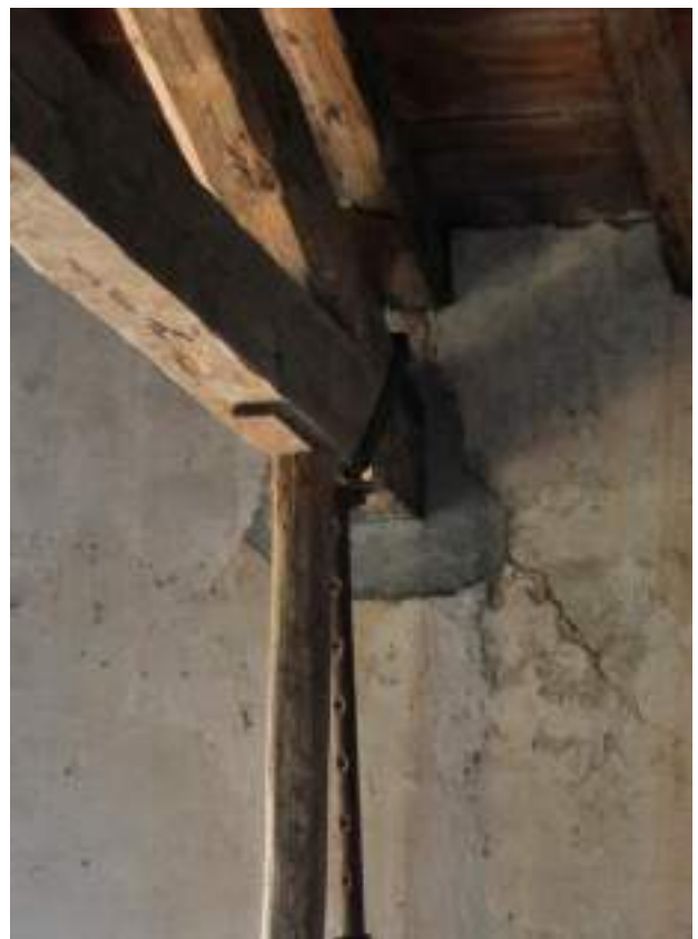
Capriata con messa in sicurezza della testa e con puntellamento provvisorio
