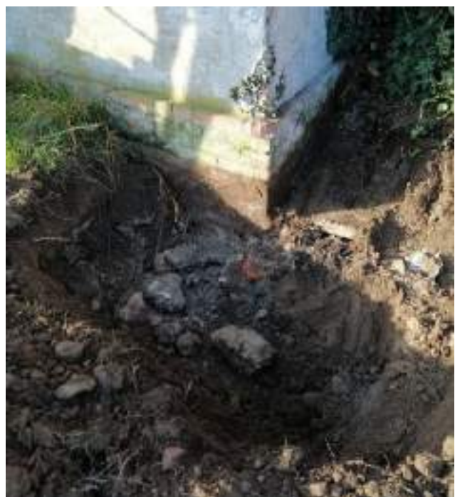
FOTO SAGGI FONDAZIONI
