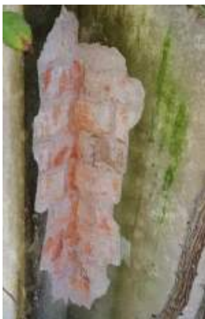
FOTO SAGGI AMMORSAMENTO TRA MURATURE DI FACCIATA E DI SPINA
