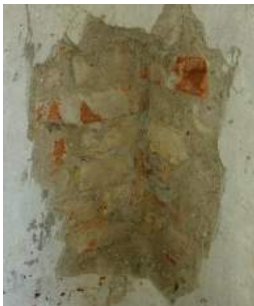
FOTO SAGGI AMMORSAMENTO TRA MURATURE DI FACCIATA E DI SPINA
