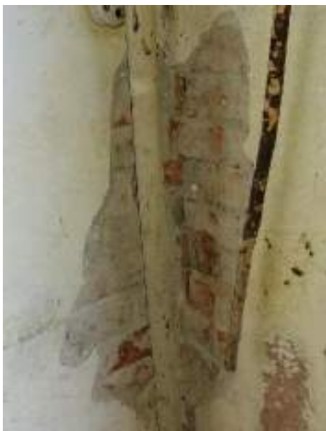
FOTO SAGGI AMMORSAMENTO TRA MURATURE DI FACCIATA E DI SPINA
