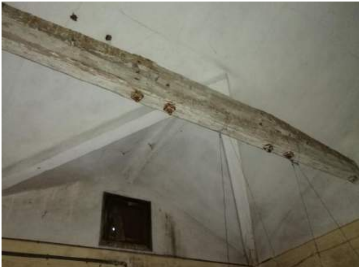
FOTO RILIEVO SOLAO S2.3
