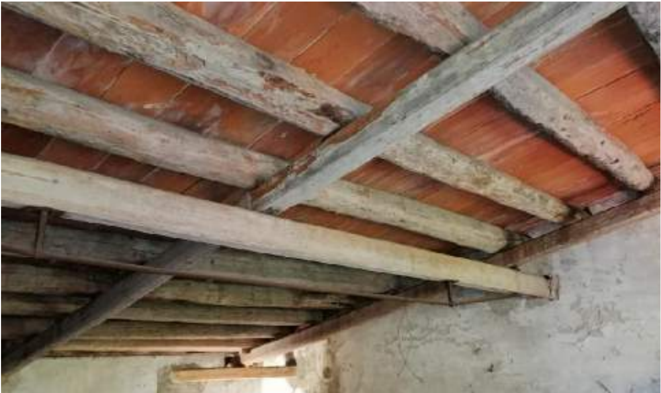
FOTO RILIEVO SOLAO S2.2
