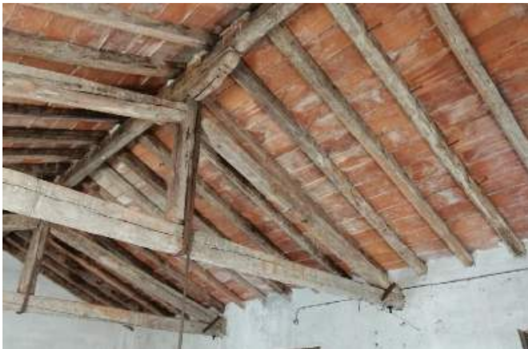
FOTO RILIEVO SOLAIO S2.1
