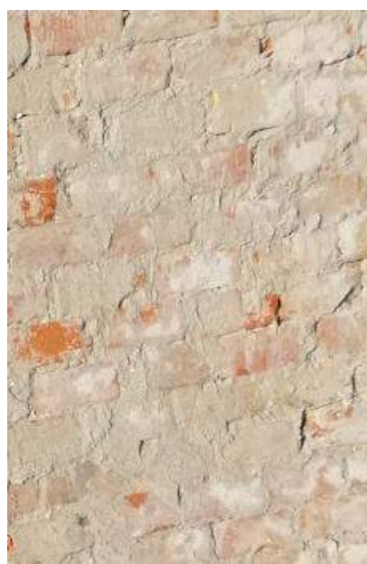
FOTO SAGGI AMMORSAMENTO TRA MURATURE DI FACCIATA E DI SPINA
